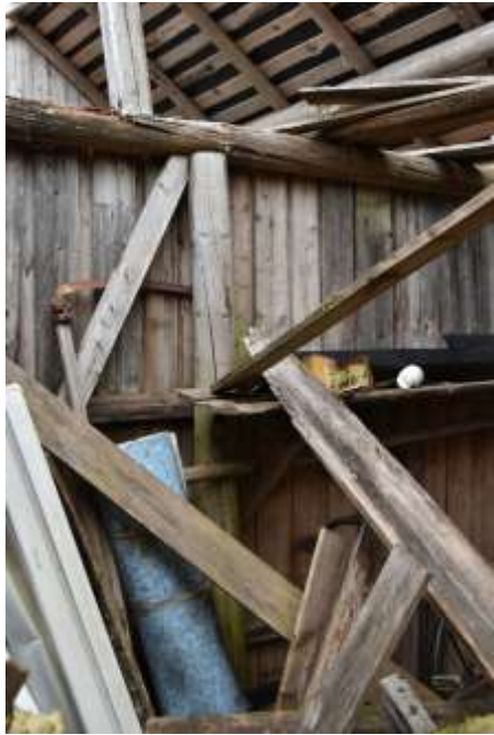
Uthuset er bygd i bindingsverk, så det var vanskelig å finne annet enn takstokker å ta prøver av. Resultatet tyder på at det var bygninger i Rybråten 1829, før Arnts tid.
