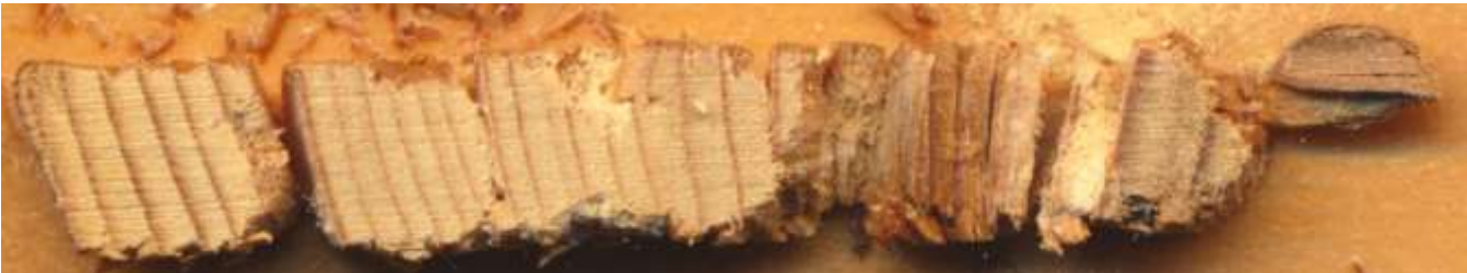
dårlig ved A7
