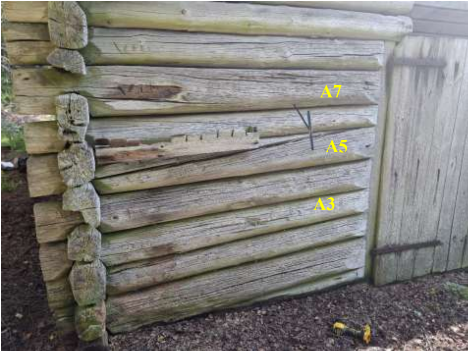
På inngangsveggen er det tatt prøver både fra innsiden og utsiden, alle viser 1785-1795
