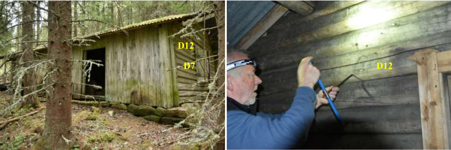
Både stokkhverv 7 og stokkhverv 12 (bildet) på østveggen ga tydelige utslag på grantømmer hogd 1870.
